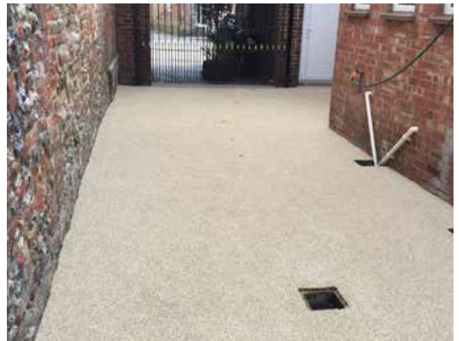
Surface nettoyée par Blastoff
